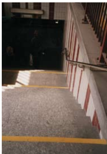
Fig. 2.1.4x Trap met ononderbroken contrasterende strips op de eerste en op de laatste trede. Vanaf deze positie is niet te zien of ook de eerste en de laatste trede op het verticale gedeelte van de trede zijn gemarkeerd, dat zou ideaal zijn.
