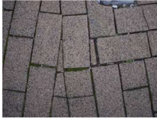
Fig. 3.1c Scherpe punten (<45°) en vulstenen kleiner dan een halve steen mogen niet worden gebruikt, omdat het risico op breuk en verzakkingen daarbij groot is.
