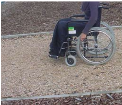
Fig.2.1.5.d Een wandelpad met een semi-verharding
